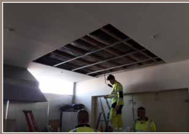
► Pose de dalles au plafond du local des Vieux Crampons.
