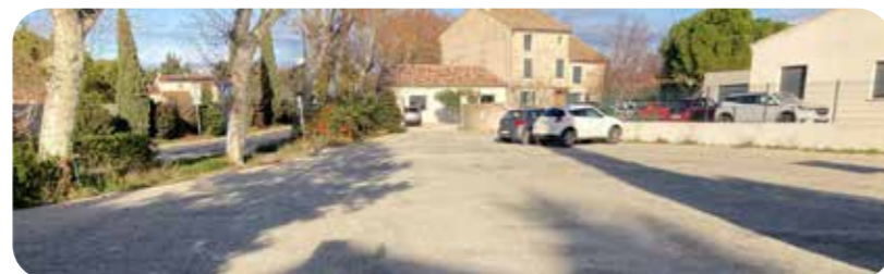
TRAVAUX PARKING CHEMIN VIEUX
