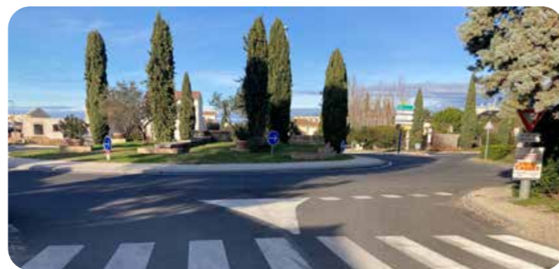
TRAVAUX ROUTE DE VALRÉAS
