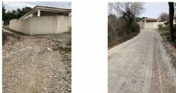
AVANT TRAVAUX APRES TRAVAUX
